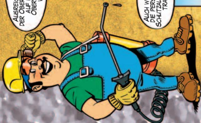
AUSREICHENDES VORNÄSSEN DER OBERFLÄCHE, WENN BETON AUF EINER SAUGENDEN OBERFLÄCHE EINGEBAUT WERDEN SOLL.
