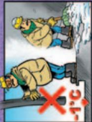
MASSNAHMEN 2, 3, 4, 5, 6: ANWENDUNG EINZELN ODER KOMBINIERT, SODASS DIE BETONTEMPERATUR AN DER OBERFLÄCHE DES JUNGEN BETONS NICHT UNTER +3 °C ABSINKT BIS DER GEFRIERBESTÄNDIGKEIT (DRUCKFESTIGKEIT 5,0N/MM<sup>2</sup>) ERREICHT HAT.
