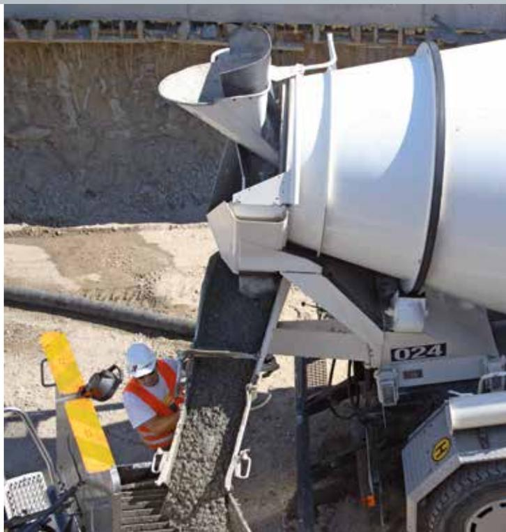
*für die Aufstellung der Betonpumpe bzw. des Fahrmischers zur Verfügung zu stellen. Die Informationen über den sicheren Aufstellungsort der Betonpumpe sind in das Baustellenerfassungsblatt aufzunehmen. Der Auftragnehmer hat das Recht, den Aufstellungsort bei sicherheitstechnischen Bedenken abzulehnen.*
