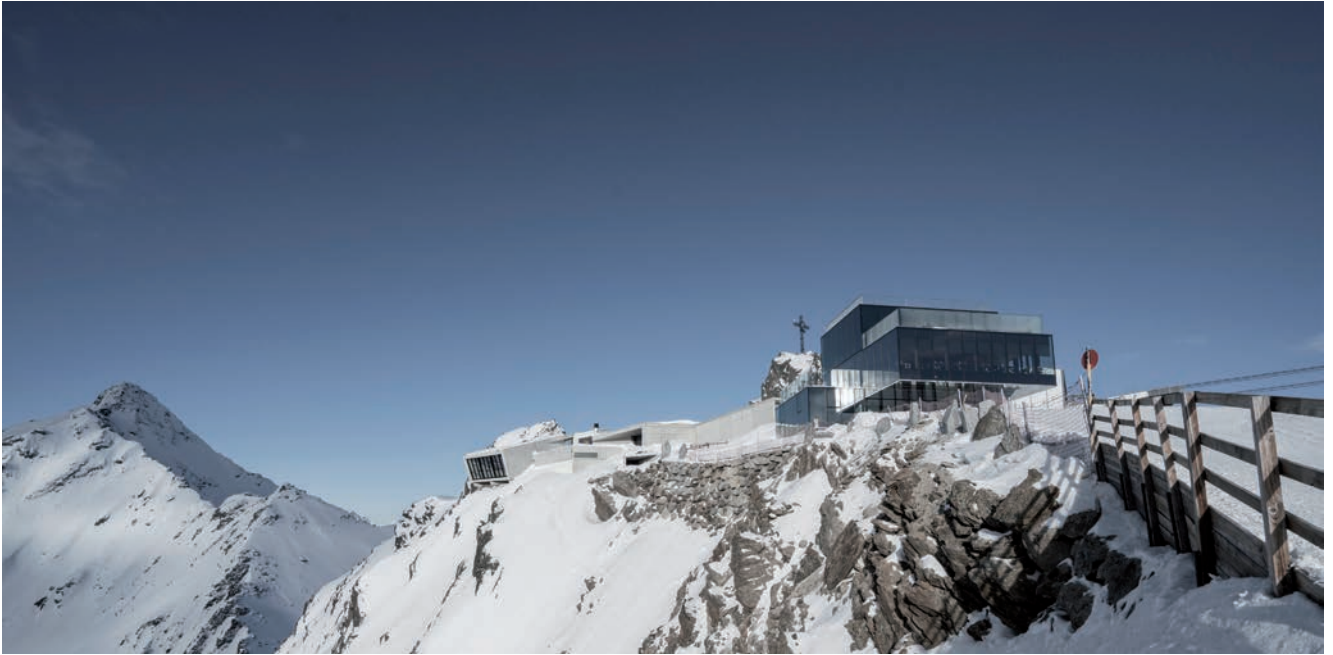
Im ewigen Eis auf der Bergspitze wurden beeindruckende 400 Tonnen Stahl und 2.700 m 3 Beton verbaut.
