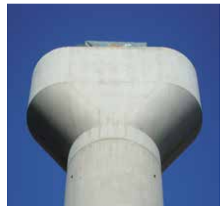
Gelungenes Beispiel für Sichtbeton: Der Stützenkopf Vorlanddonaubücke in Traismauer
