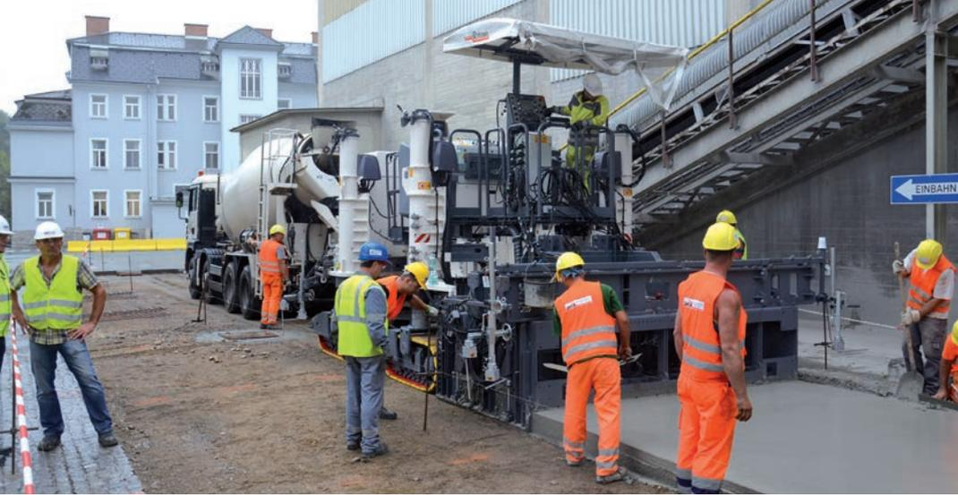
Beide Bilder: Am Gelände der Fa. Lafarge in Retznei wurde das Einbauverfahren mit einem Betonfertiger erprobt (PCC).
