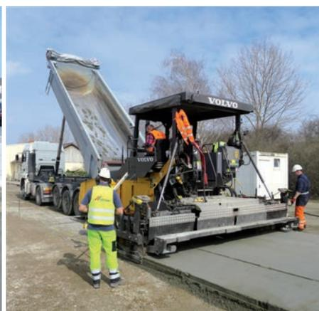
Beim sogenannten „Walzbeton“ wird der Beton mit einem umgebauten Asphaltfertiger eingebaut und anschließend mit Walzen verdichtet. Auch dazu wurden in Österreich schon erfolgreiche Teststrecken eingebaut.
