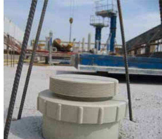
Wiederverwendbarer Deckensensor an der Deckenoberseite
