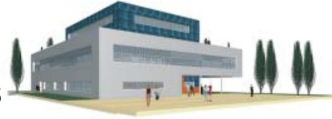
Am 26. Jänner wurde in Mödling bei Wien SOL4, das größte Büropassivhaus Österreichs, eröffnet. Aus ökologischen Gründen kam beim Beton das neue Bindemittel Slagstar zum Einsatz. Durch den Einsatz des Slagstar-Ökobetons konnten bei SOL4 rund 220 Tonnen CO<sub>2</sub> eingespart werden.
