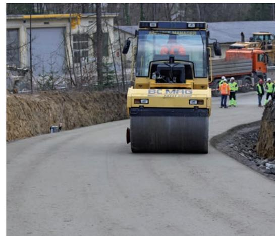
gebrochene oder ungebrochene Gesteinskörnungen, Zement und gegebenenfalls Zusatzmittel. Um einen höchstmöglichen Verdichtungsgrad zu erreichen, muss der Beton ähnlich wie bei zementstabilisierten Tragschichten zusammengesetzt werden.
