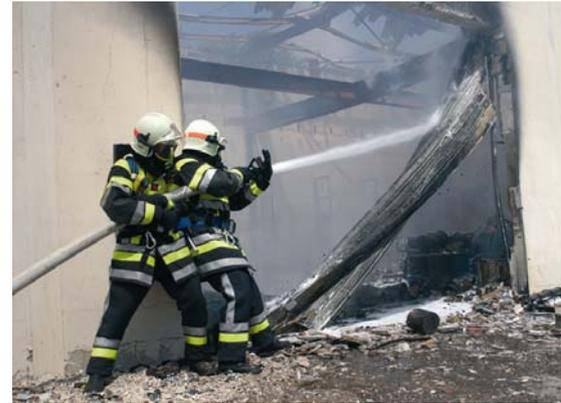
Bild 1.2: Beim Brand eines Lagergebäudes konnten sich die Feuerwehrmänner hinter einer Betonwand so schützen, dass sie zum Löschen der Flammen nahe genug an das Feuer herankamen. (Quelle: DMB/Fire Press – Revue soldats du feu magazine, Frankreich)
