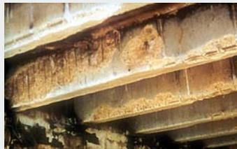
Bild FB 1.2: Beispiel von Betonbauteilen nach dem Brand mit Abplatzungen (Quelle: DBV, Deutschland)
