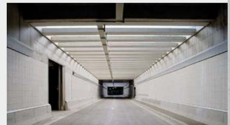
Bild FB 5.2: Kinkempois-Tunnel (Verbindung E25 – E40) in Lüttich, Belgien, mit einer Fahrbahndecke aus Beton. Betonfahrbahndecken halten den extremen Temperaturen stand, die bei Tunnelbränden vorherrschen. (Quelle: photodaylight.com)
