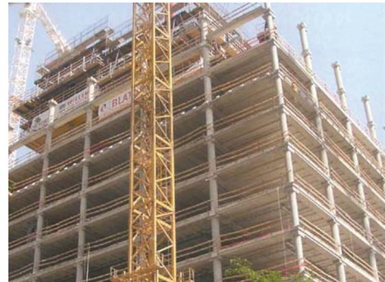
Bild 1.3: Das 30-stöckige Stahlbetongebäude „North Galaxy Towers“ in Brüssel erfüllt die geltenden hohen Anforderungen an den Feuerwiderstand REI 120; die Stützen bestehen aus hochfestem Beton C80/95. (Quelle: ERGON, Belgien)
