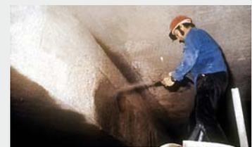
Bild FB 1.3: Instandsetzung von Bauteilen mit Spritzbeton (Quelle: DBV, Deutschland)
