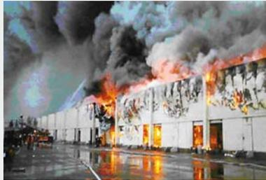
*Bild FB 8.1: Die Sandwichplatten in Metall-Leichtbauweise versagten bei diesem Brand in einem Schlachthaus in Bordeaux (Frankreich) im Jänner 1997. Der Brand breitete sich über das gesamte Gebäude und auf angrenzende Gebäude aus. (Quelle: SDIS 33, Fire and Rescue Service, Gironde, Frankreich)*
