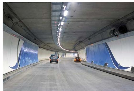
Bild 1.4: Cointe-Tunnel (Verbindung E25 – E40) in Lüttich, Belgien. Tunnel aus Beton mit Betonfahrbahndecken können den extremen Brandbedingungen bei Tunnelbränden widerstehen. (Quelle: photo-daylight.com)
