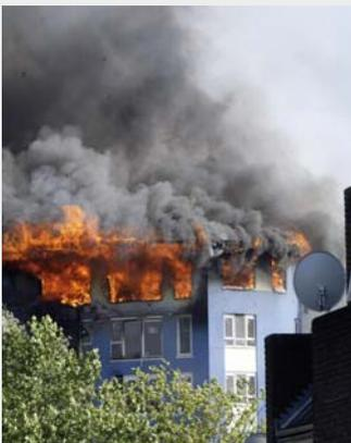
Bild FB 6.1: Der Brand in den erst teilweise errichteten Wohnblocks in Holzbauweise in Colindale wütete fünf Stunden lang. 100 Feuerwehrleute und 20 Löschfahrzeuge waren nötig, um ihn unter Kontrolle zu bringen. (Quelle: John-Macdonald-Fulton, GB)
