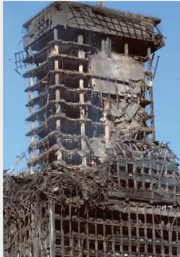
Bild FB 3.3: Die Fassade oberhalb der technischen Etage im 16. Stock wurde völlig zerstört. (Quelle: IECA, Spanien)
